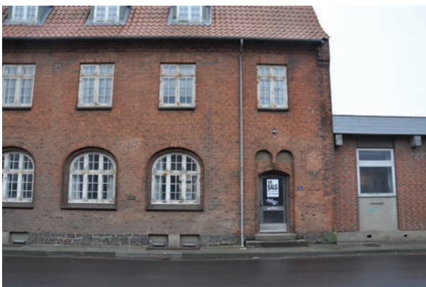
Posthusbygning er i dag solgt
