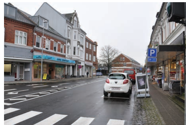
Storegade set mod hævet plade ved Sct. Knuds Allé
