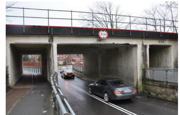
Viadukten - en fysisk og visuel barriere
